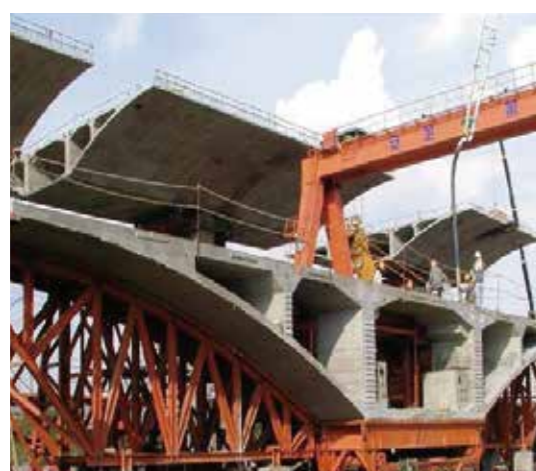
2000年高速公路(快官段)亞洲最大橋梁結構
