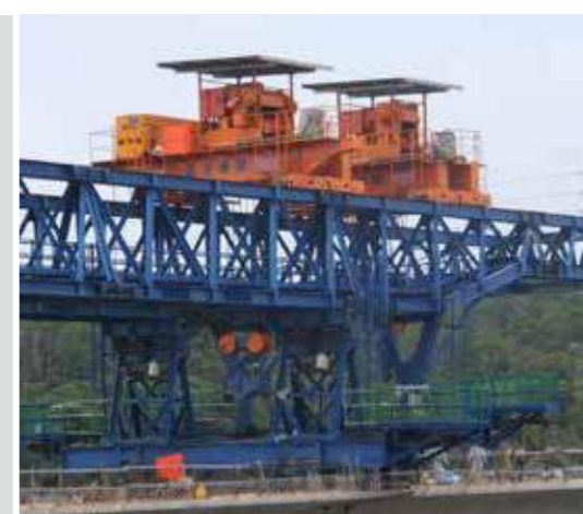
2011年皇昌營造五楊段高速公路工程
