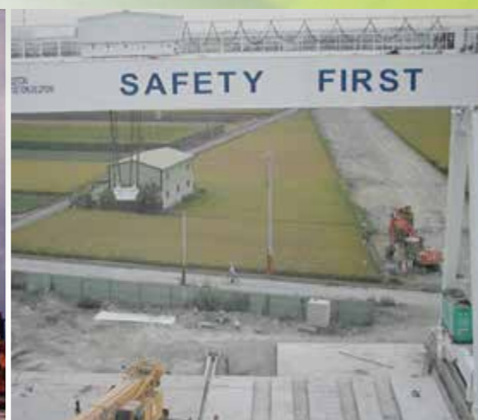
2001年台灣高速鐵路100噸門型吊車
