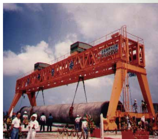
1988台北八里門型工程200噸門型吊車
